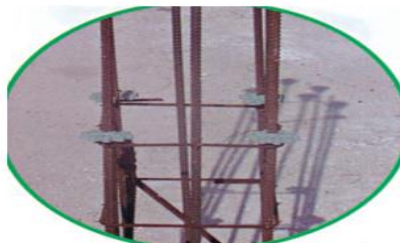
COLOCACIÓN EN PILARES
