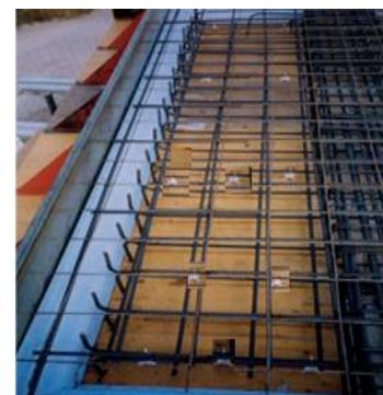
**DISTANCIA RECOMENDADA DE 50 a 90 cm**, DEPENDE DEL TIPO DE ARMADURA, BARRAS CORRUGADAS Ó MALLA ELECTROSOLDADA Y Ø DE LAS MISMAS.
